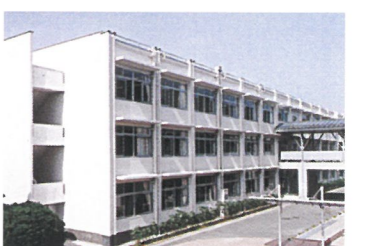
南覺舎(平成13年1月改修)
